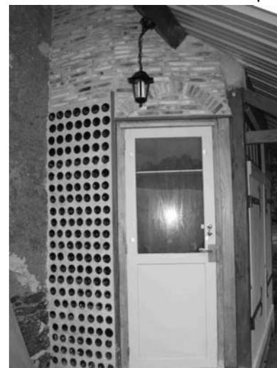
vitrée avec au dessus un linteau voûté en brique réfractaire (au travail). La façade ouest est constituée d'une porte à deux battants qui donne une ouverture totale sur les toilettes qui permet un accès pour amener la
